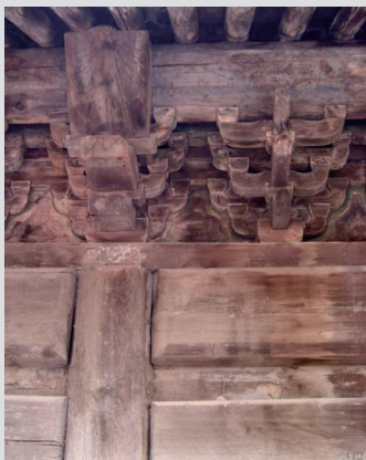
斗拱将承重传递到柱上
