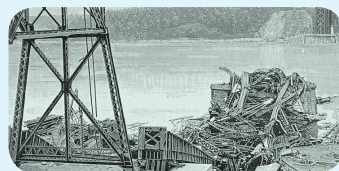
图 1-8 坍塌后的魁北克大桥
